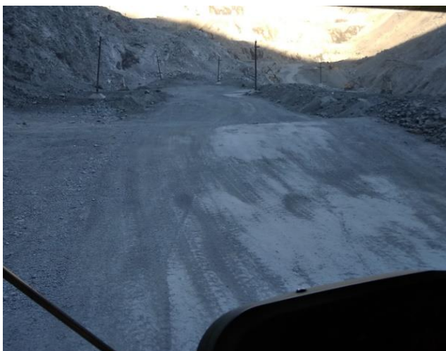
Рисунок 2 - Пример технологической дороги с не правильным профилем вызывающий продольные и диагональные перегрузки металлоконструкции автосамосвалов
