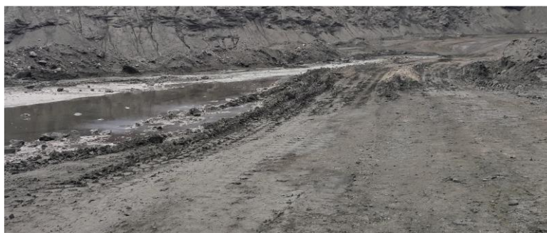
Рисунок 3 - Пример технологической дороги с плохим дренажом
