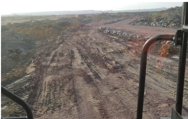
Рисунок 4 - Пример технологической дороги с пластической деформацией
