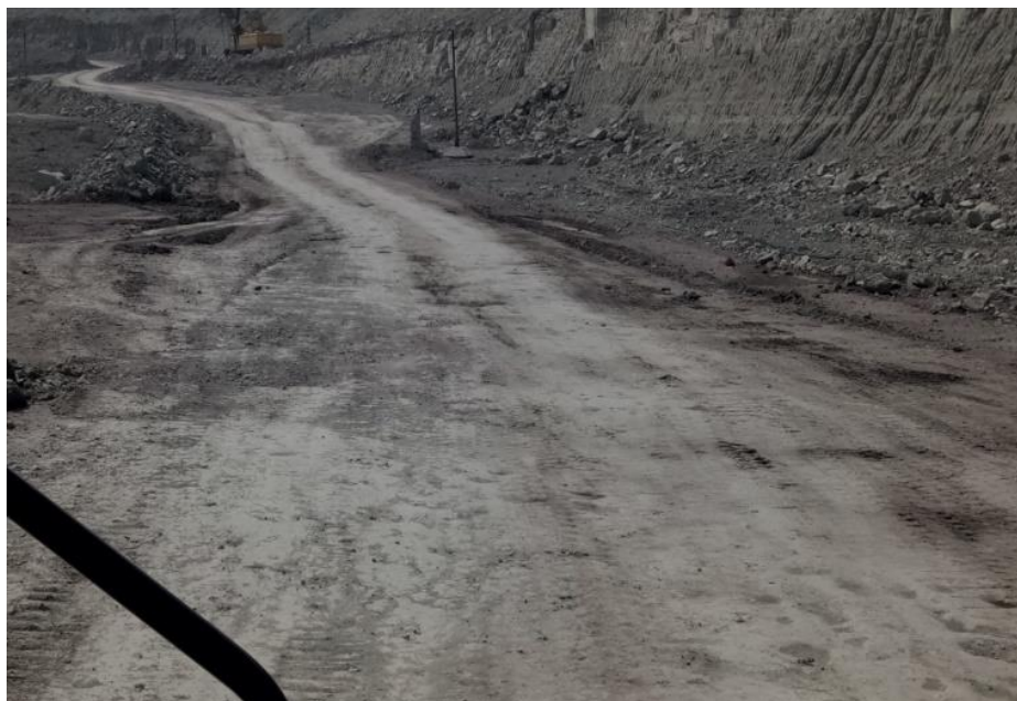
Рисунок 1 - Пример технологической дороги не достаточной ширины и деформациями в виде выбоин
